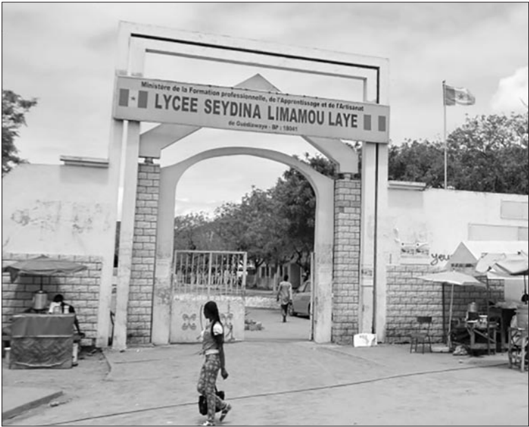
Au lieu d'une réhabilitation, le lycée Limamou Laye sera entièrement reconstruit sur instruction du Président Macky Sall.
